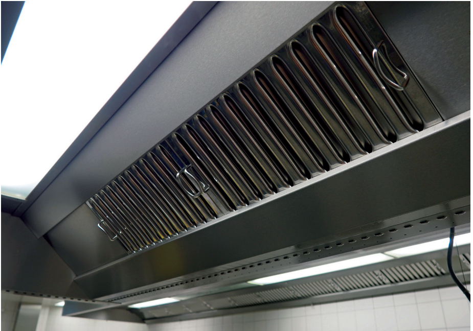
Abb. 22: Aerosolabscheider auch Flammenschutzfilter genannt
