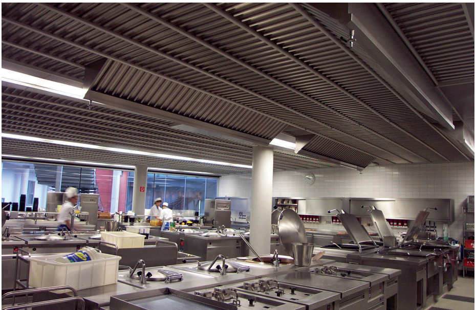
Abb. 2: Küchenlüftungsdecke
