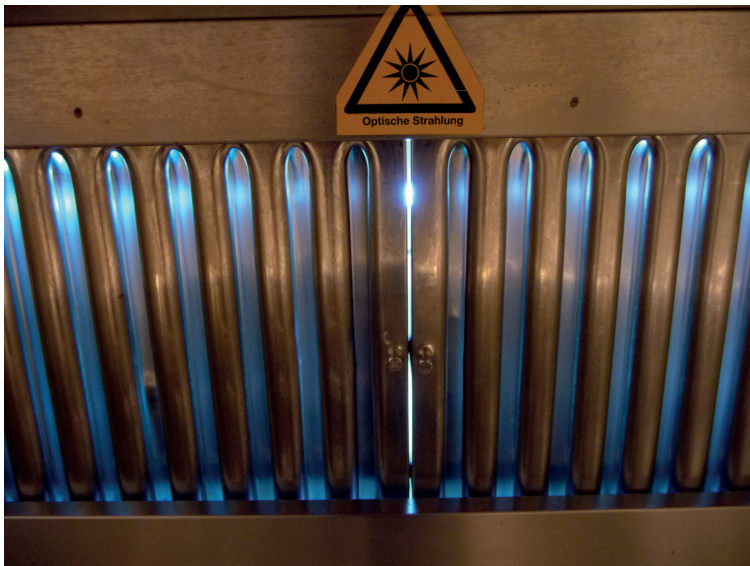
Abb. 10: Falsch und unzulässig: sichtbares blaues Licht von den UVC-Röhren
