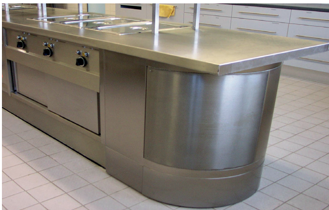
Abb. 15: In das Küchenmöbel integrierter halbzyklindrischer Quellluftdurchlass.
