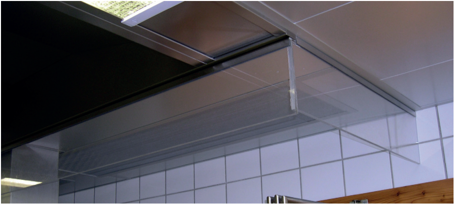
Abb. 19: Verdrängungsluftdurchlass mit Schürze
