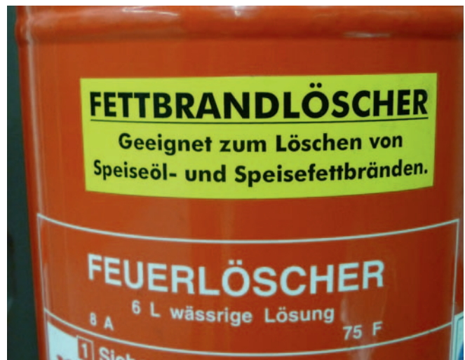
Abb. 12 Kennzeichnung eines für Fettbrände geeigneten Feuerlöschers
