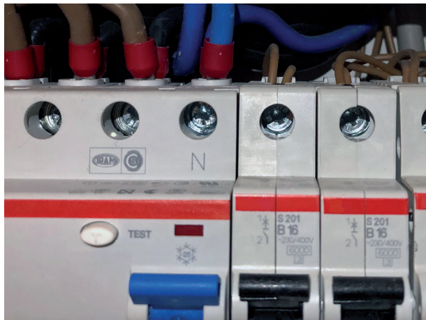
Abb. 3: Verdeckter (fingersicherer) Einbau von Anschlussklemmen
